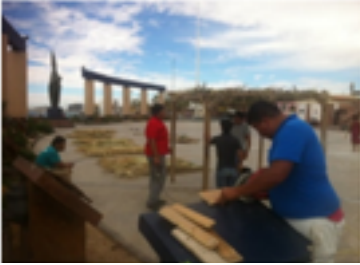
Fig. 3 proceso de construcción.
