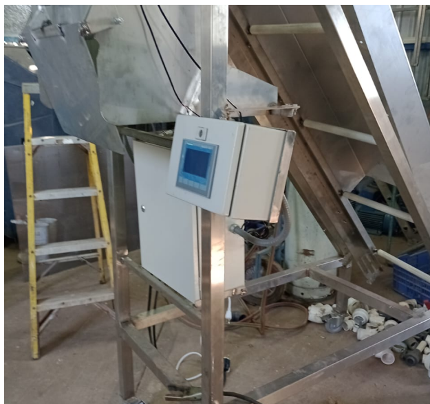
Figura 10. Instalación de gabinete y HMI.
