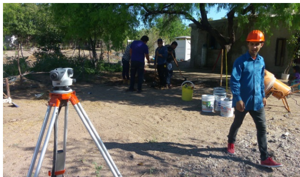
Figura 3. Localización, trazo y despalme del terreno.
