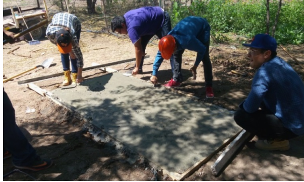
Figura 4. Losa de cimentación.
