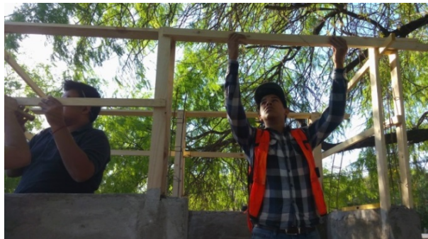
Figura 7. Techumbre y acabados.
