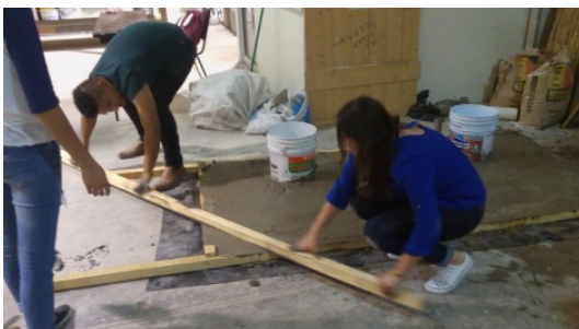
Figura 8. Colado de piso.
