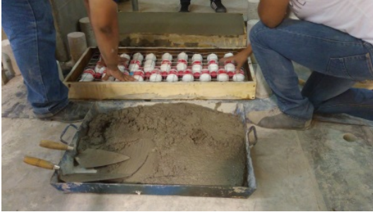
Figura 10. Elaboración block muro.
