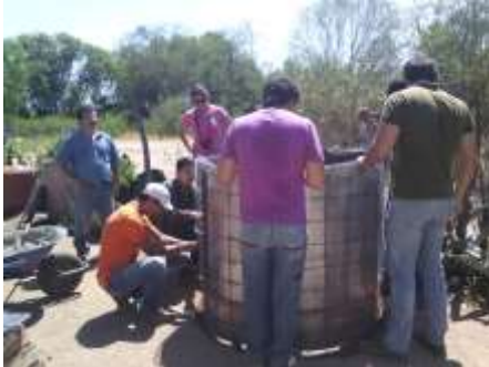
Figura 6. Excavación para desplante.
