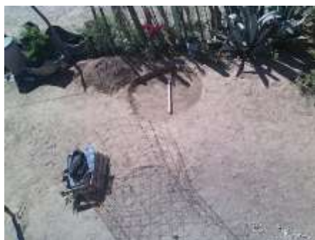
Figura 4. Excavación para desplante.
