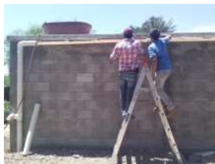
Figura 9. Colocación de la canaleta.
