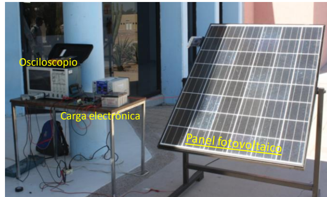
Figura 2. Panel solar fotovoltaico y circuitería de prueba.
