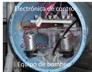
Fig. 5 Localización del sistema de control y bombeo instalado dentro del casco del Sub-Chaac.
