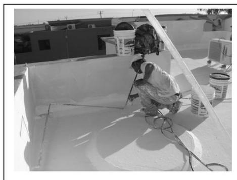
Figura 1. Impermeabilización de la losa de azotea.
