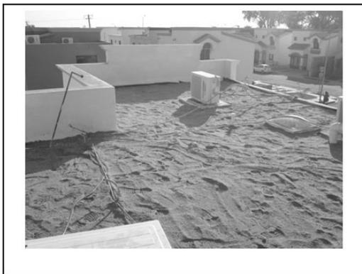
Figura 3. Colocación de la mezcla de limo, perlita y tierra de germinación en la Azotea.
