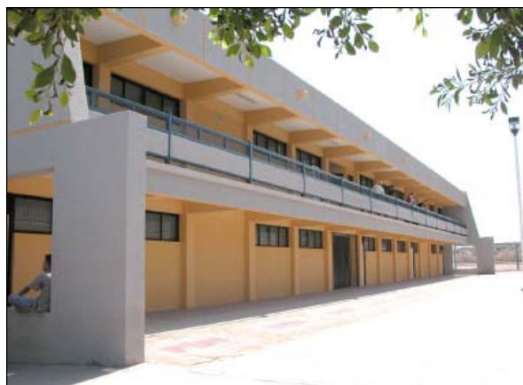
Edificio de Laboratorios y Audiovisuales, ubicado en la Unidad Guaymas.
