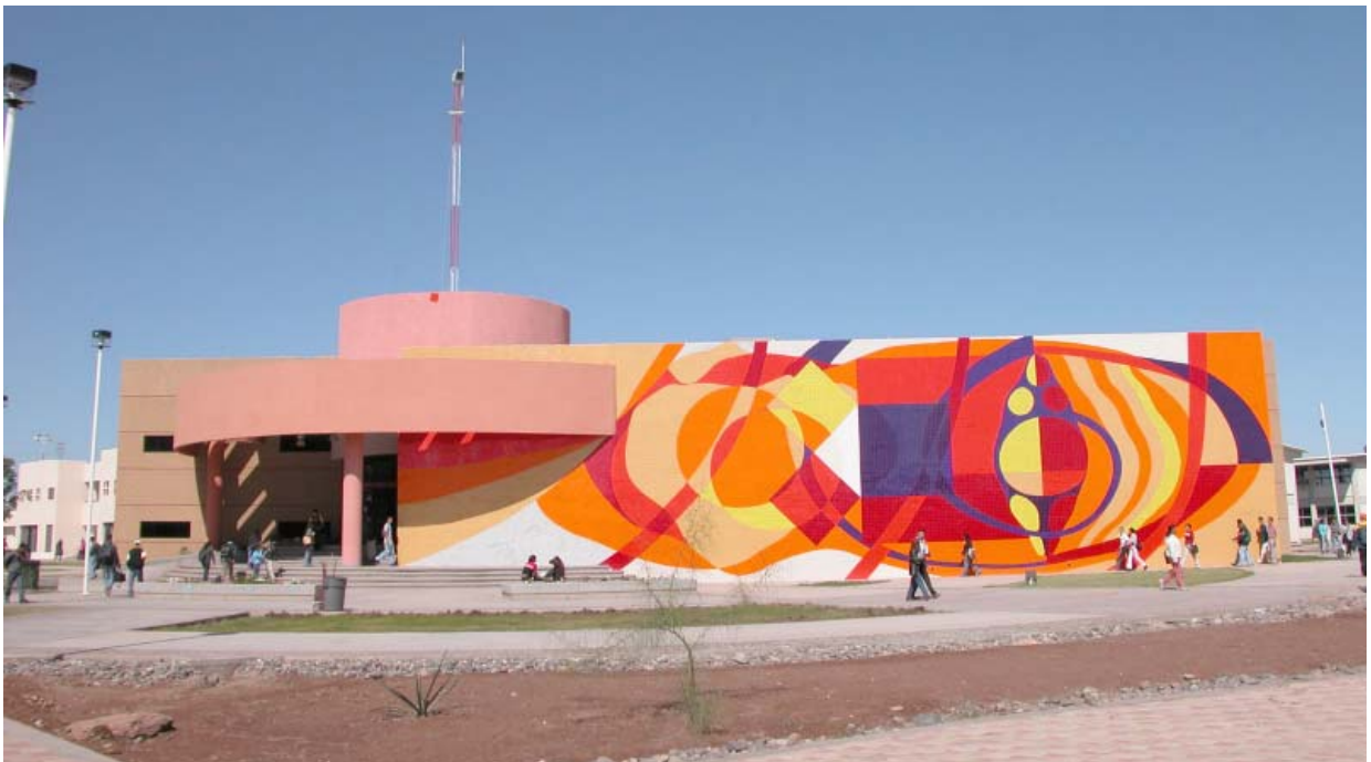
Vista general del Centro de Informática y Servicios en Computación (CISCO), en Campus Nainari del ITSON.
