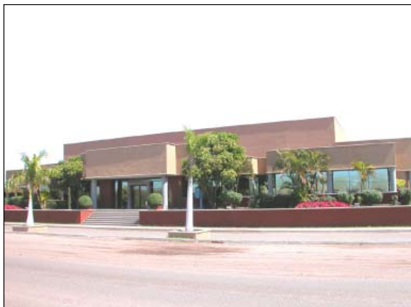
Casa Club ITSON ubicada en Campus Náinari.
