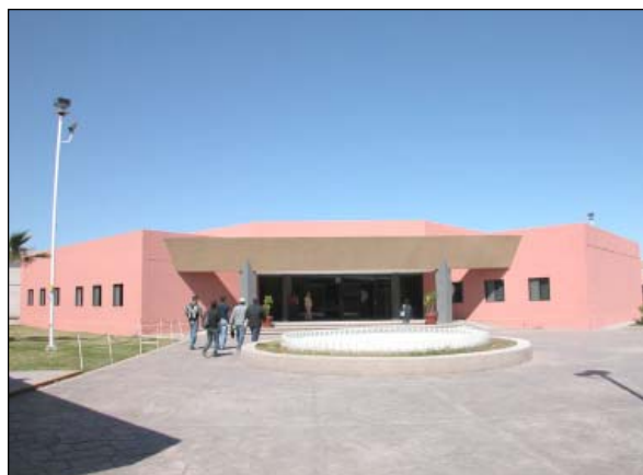
Panorámica del Edificio de Videoconferencias, ubicado en el ITSON Campus Náinari.
