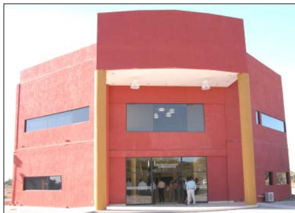
Panorama del nuevo edificio Académico y Administrativo del ITSON Unidad Navojoa.
