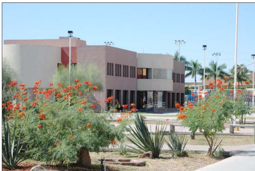
Panorámica del Centro de Apoyo para Docentes (CAD), ubicado en Campus Náinari.
